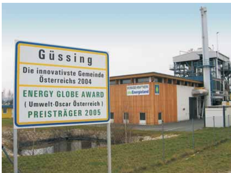
Biomasse-Kraftwerk (Foto: © EEE GmbH)
